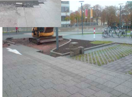
Fertigstellung Feuerwehrumfahrung und Parkplätze Nordseite Parhaus
