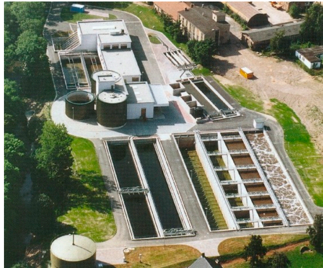
Luftaufnahme der Kläranlage
