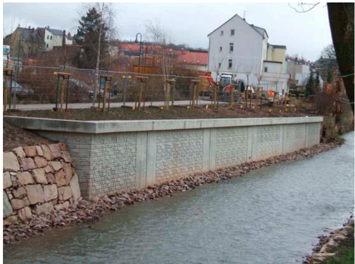
Ansicht Stützwand Los 4
