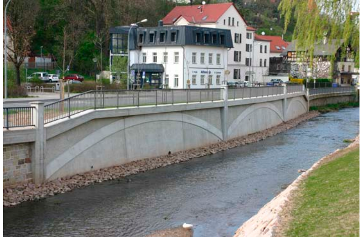
Ansicht Stützwand Los 3
