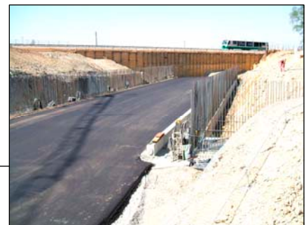
Baugrubensicherung
