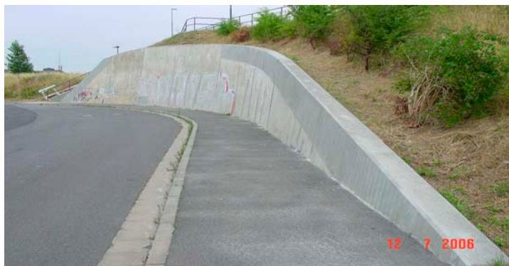
BW 0119 Stützwand nordöstlich des Brehnaer Überbaus monolithische Winkelstützwand
